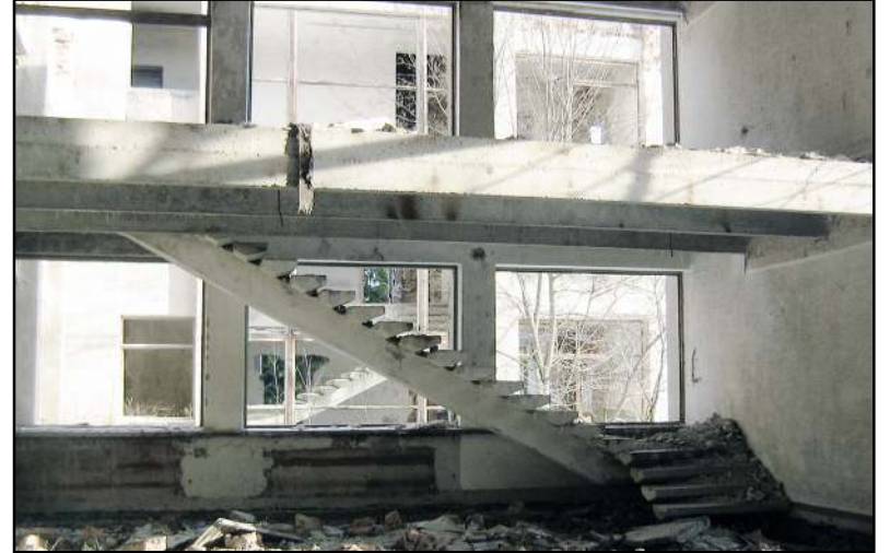
Pastato viduje - konstrukcijos, kurios vos laikosi
