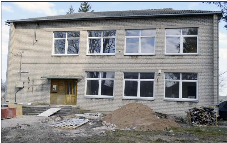
Turgaus aikštės pašonėje pradėtas remontuoti privačiam asmeniui priklausantis seniūnijos pastatas
