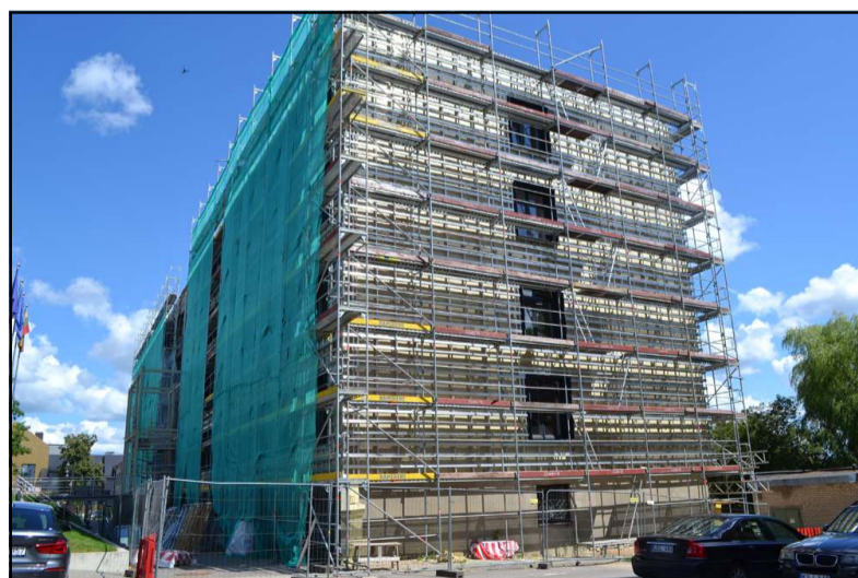
Galų gale savo eilės renovacijos procese sulaukė ir savivaldybės pastatas
