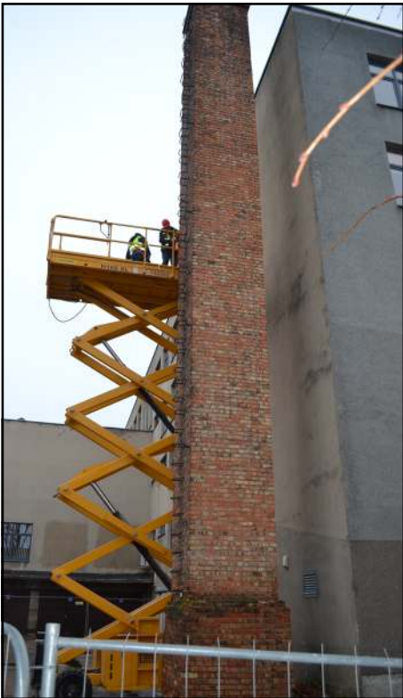
Pradėjus renovuoti savivaldybės pastatą, išardytas ir didžiulis mūrinis kaminas
