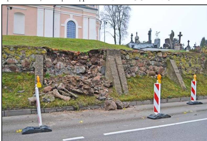
Ekspertizės metu konstatuota, kad Molėtų Šv. Petro ir Povilo bažnyčios akmeninė tvora šiuo metu yra kritinės arba avarinės būklės, esama tiesioginės griūties grėsmės
